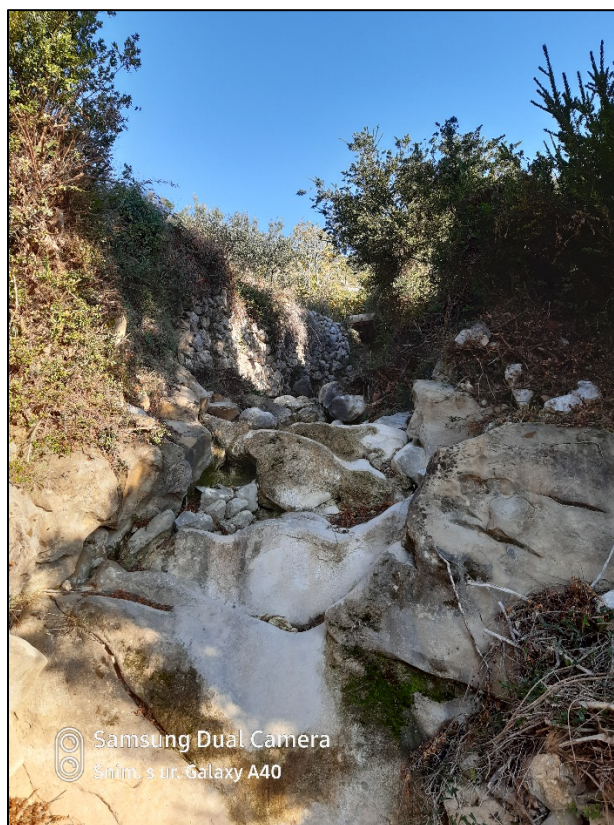
Slika 7. Neregulirani uzvodni dio bujice Brusje – Crni Dol (Šuškovac)
