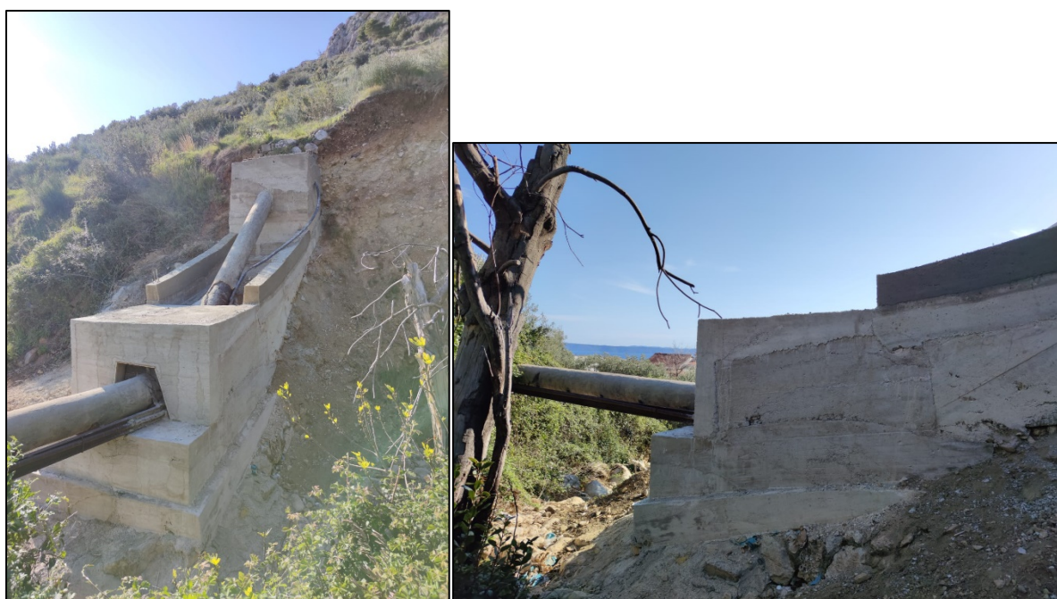
Slika 4. Postojeće stanje regionalnog cjevovoda vodoopskrbe na području prelaska preko bujice, nakon stabilizacije
