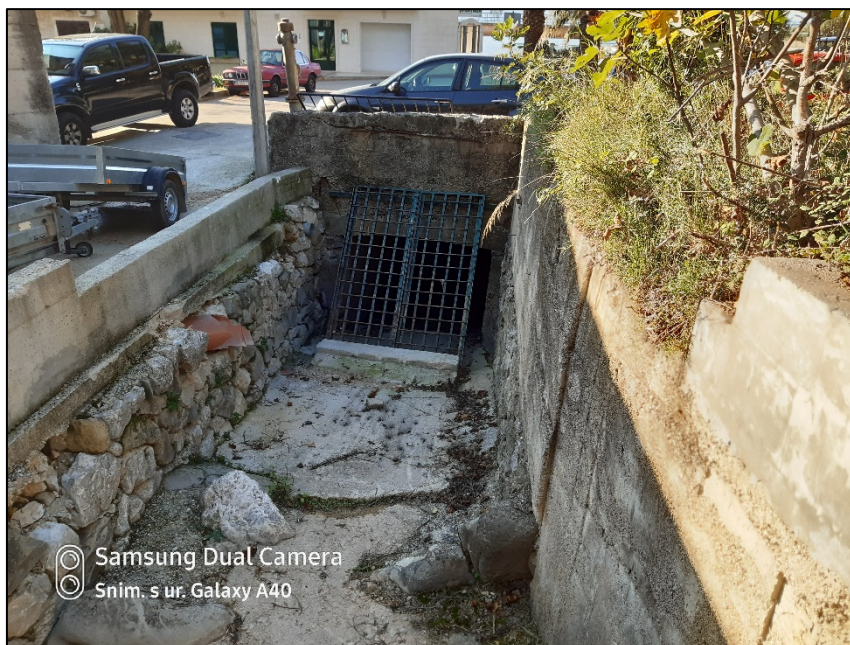
Slika 6. Regulirani nizvodni dio bujice Brusje – Crni Dol (Šuškovac)
